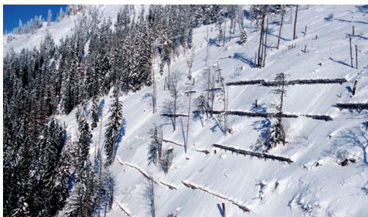
Wenn ein wirksamer Schutzwald fehlt, sind teure technische Verbauungen nötig. Lawenschutz am Bläserberg SG. (Bild: R. Schwitter)
